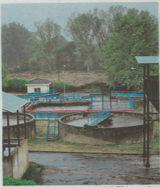
Instalaciones de la depuradora, en la parroquia de Piñeira. R. FERNÁNDEZ
