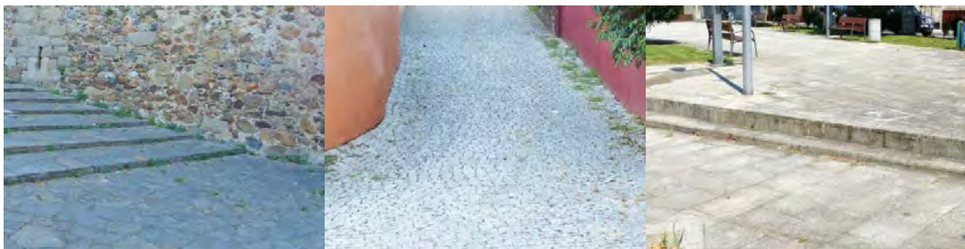
1.Chapaplana en San Vicente | 2.Lastrado de pedra nas Beiras do Cabe | 3.Lousado de pedra en Carude.
