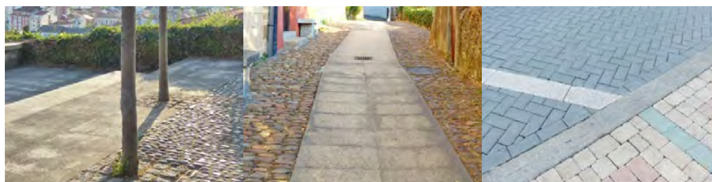
1 e 2 - Lousado e cantos rodados na Falagueira | 3. Lastros de formigón en San Vicente.
