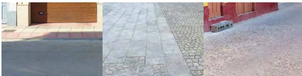
1. Baldosa e firme de formigón en Abeledos | 2. Lousado e lastro en San Antón | 3. Formigón en Santa Clara.
