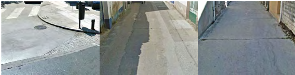
1.Lousa, lastro e formigón no Piñeiro | 2 e 3.Formigón na rúa do Conde e na Cerca.
