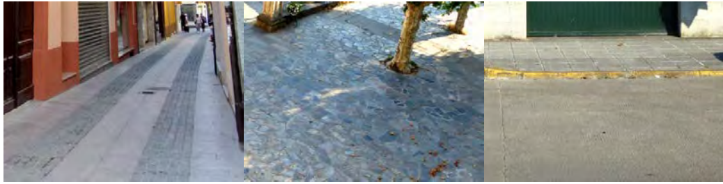
1.Lastrado e Lousa comúns no Arrabal | 2.Chapaplana en Santo Domingo | 3.Baldosa e firme de formigón no Malecón.
